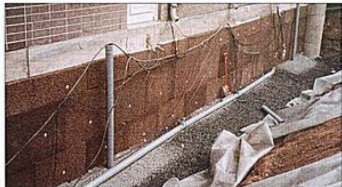
Edullinen maanpaineeseinän korjaus – täytöt kaivuunmassoilla
