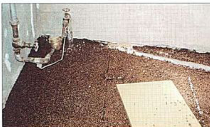
Lämmöneristys, salaojitus ja kapillaarikatko - kuivumissuunta maata kohti
