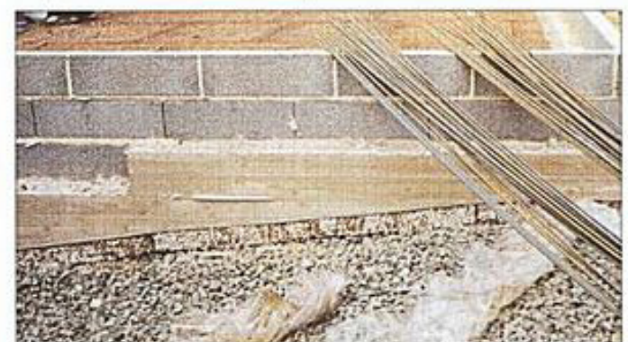
Oikeaoppinen rakenne - tiivis sisältä, ulospäin harveneva
